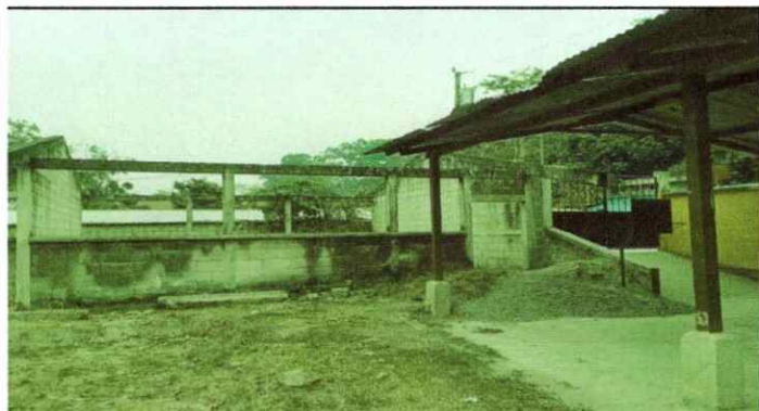
Foto 3: Módulo de colocación de balcones y puertas.
